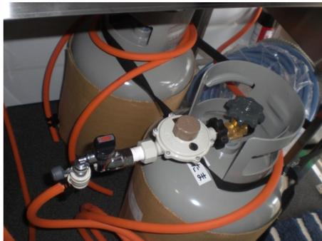
ガスボンベの開閉は基本的にしない。開けたままで良い。ガス管に平行ならOKです。
