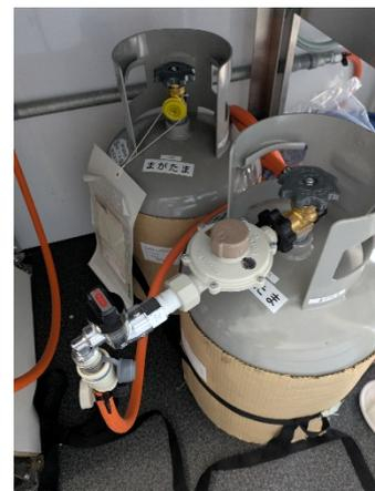
す。長期間使用していなかった場合、ホース内にガスが停滞して点火に時間がかかることがあります。必要に応じてガス元栓とホース側を開栓後、数回点火操作を行いガス供給が確実であることを確認してから調理を開始します。
